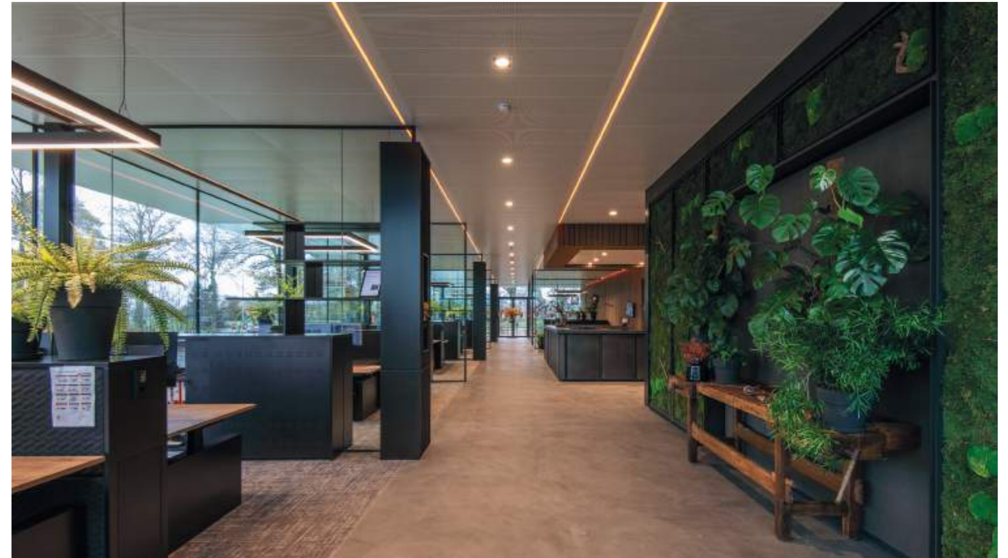
BOUWBEDRIJF VAN MIDDENDORP | WEKEROM | MAATWERK BANDRASTERPLAFOND MET LICHTLIJN EN VERDEKT SYSTEEM
