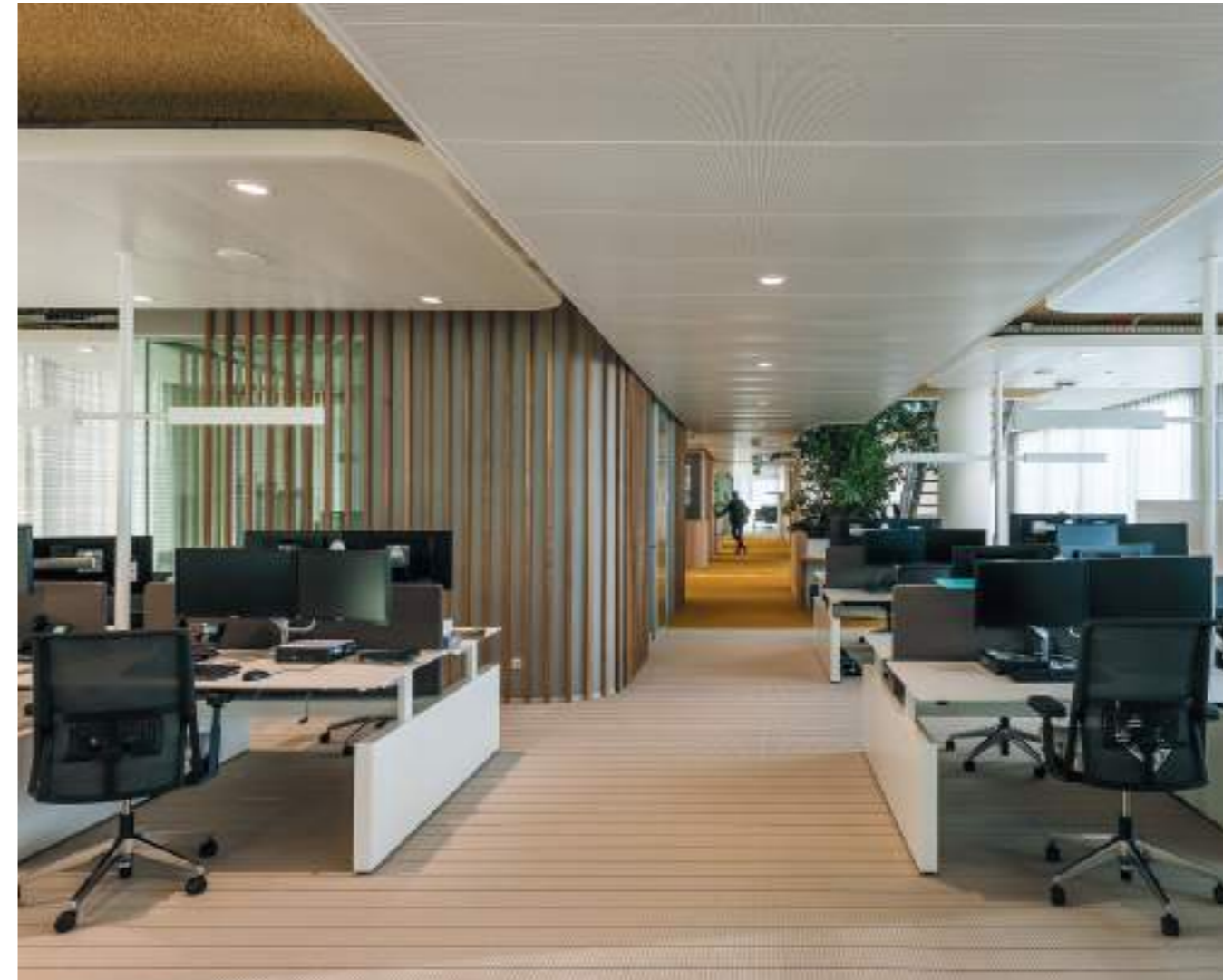
DE NEDERLANDSCHE BANK | AMSTERDAM | KLIMAATPLAFONDEILANDEN VOORZIEN VAN EEN KADER EN AFGERONDE HOEKEN
