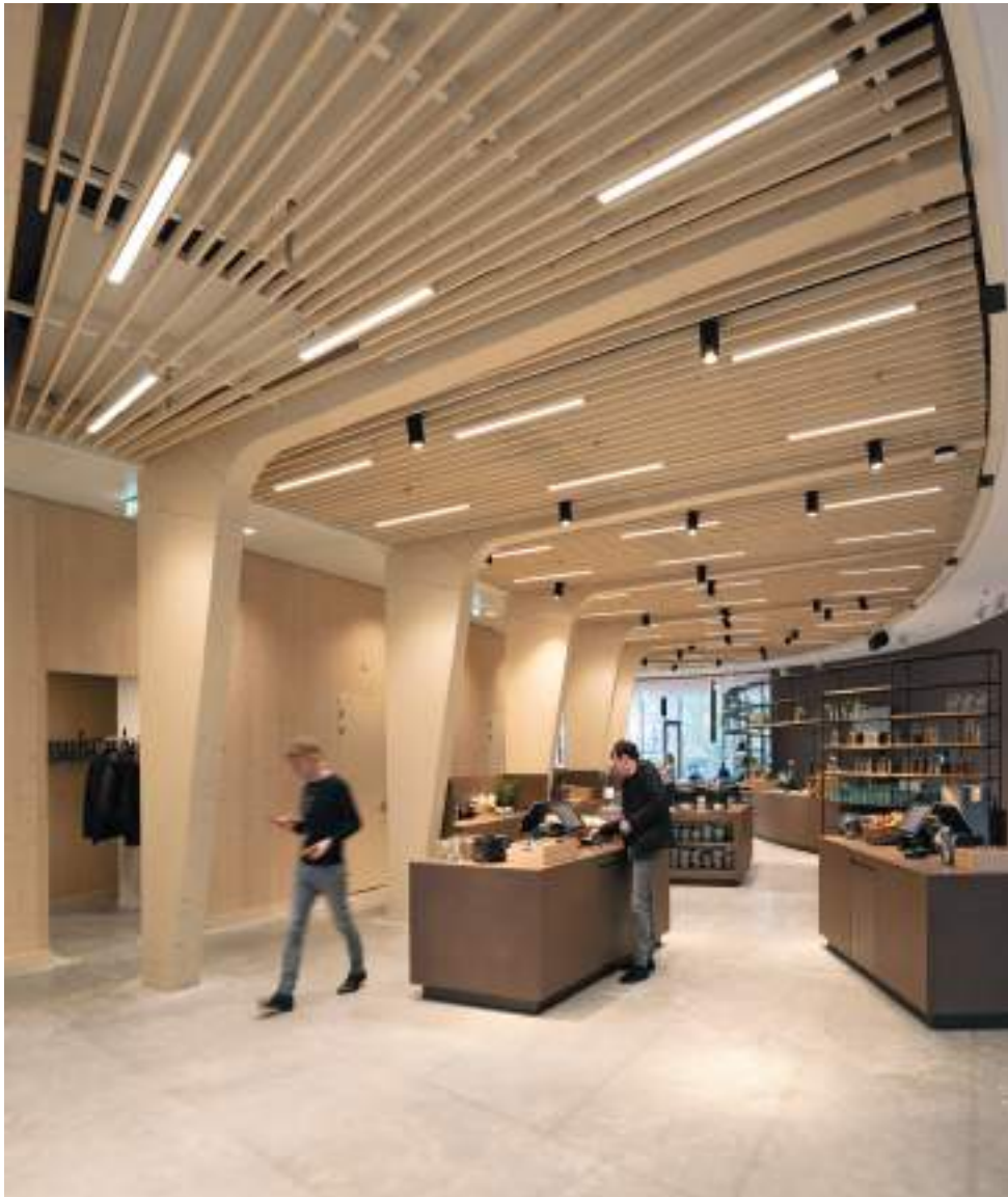
TRIODOS BANK | DRIEBERGEN-RIJSENBURG | KLIMAATPLAFOND IN COMBINATIE MET HOUTEN LAMELLEN
