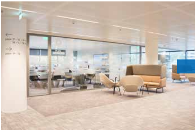
Foto gesloten plafond.
